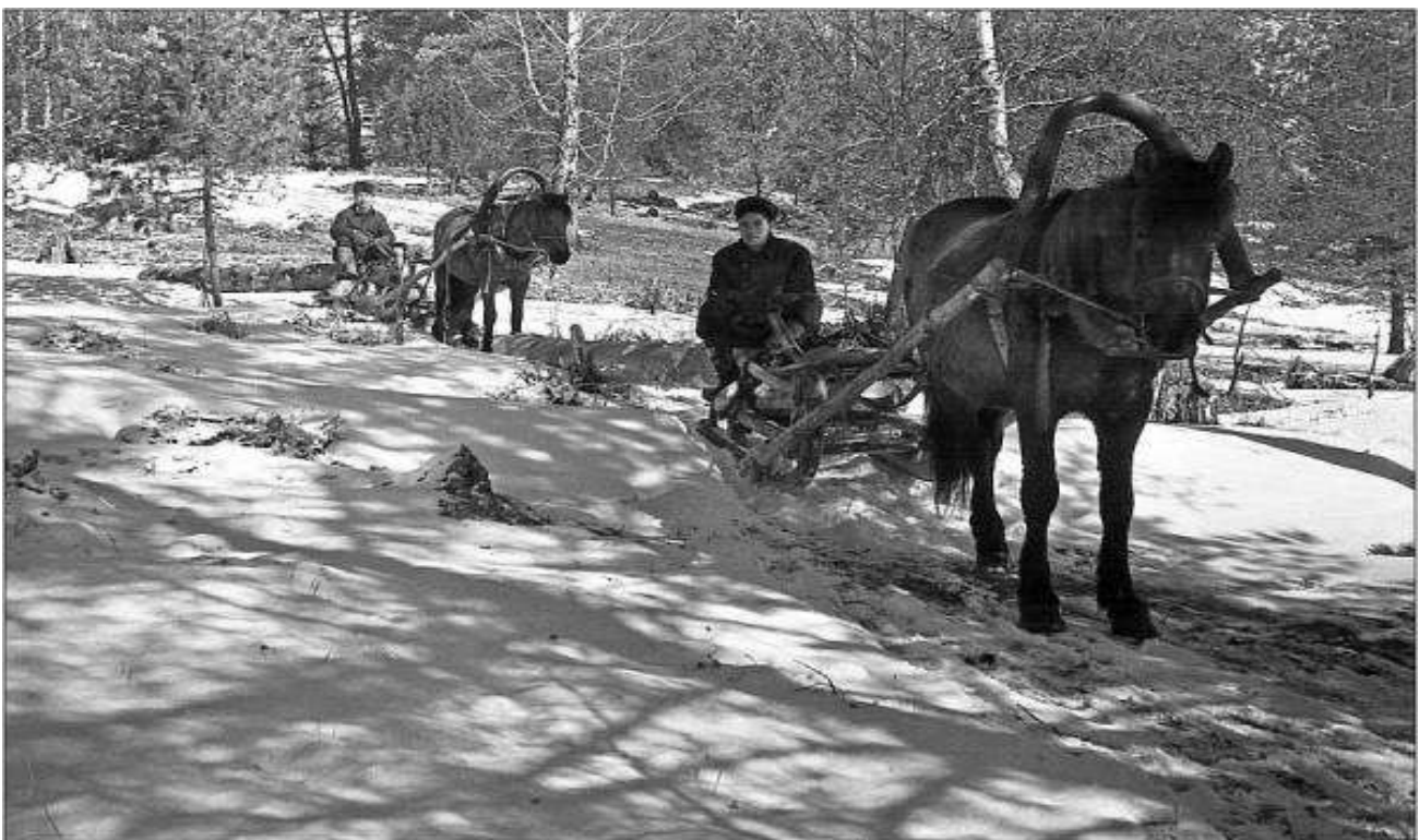
Везут лес на строительство дамбы.
