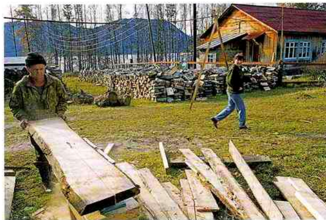
На работах в Яйлинской школе
