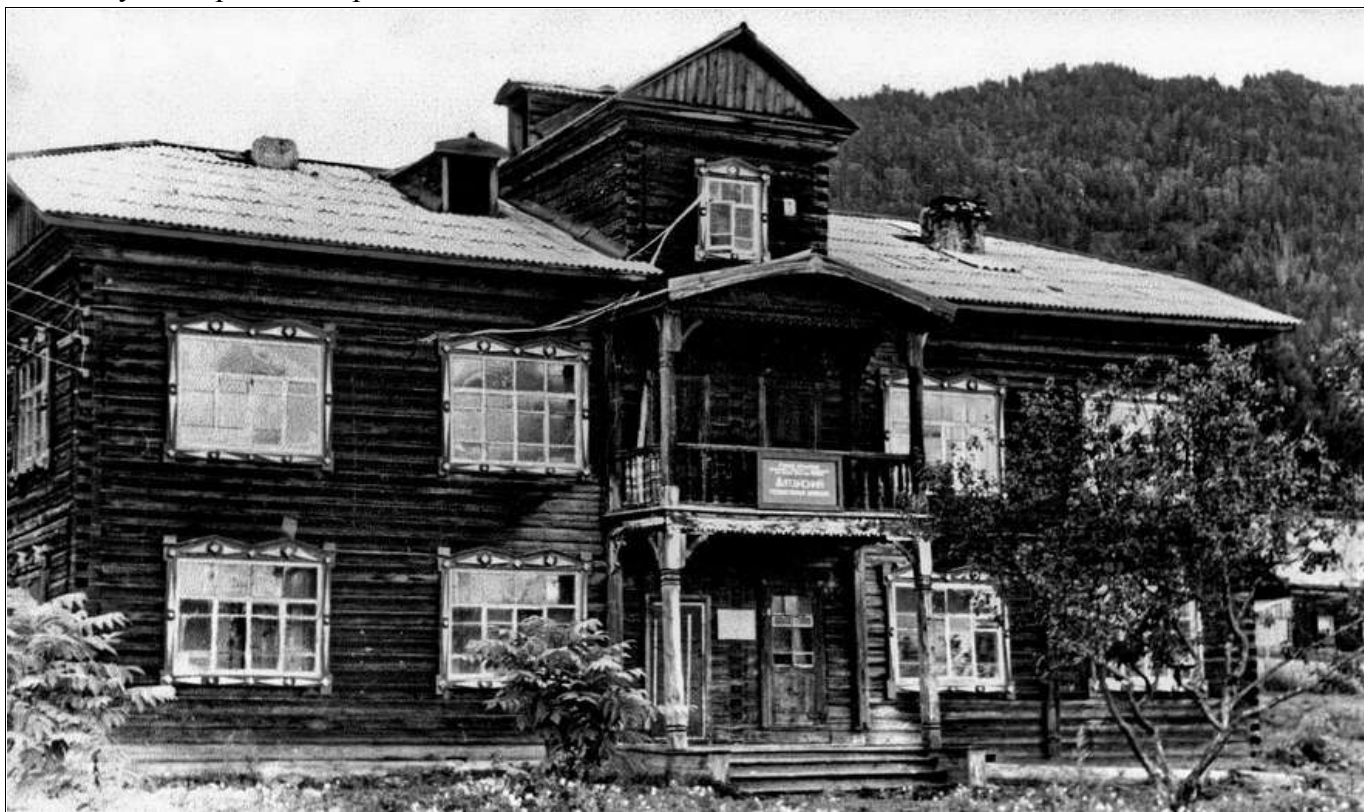
Контора заповедника. На крыше видны трубы печного отопления, которое предстояло заменить водяным. Яйлю, 1970 г.
